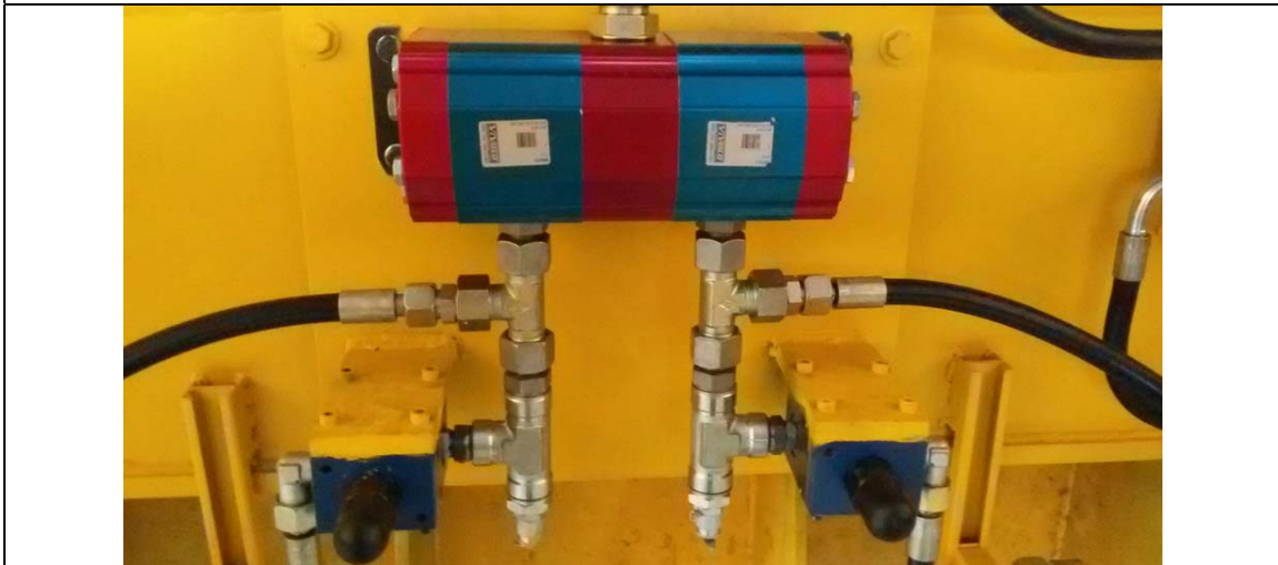
نمونه پروژه تقسیم جریان 0.3lit/min و 100lit/min به دو مقدار مساوی
