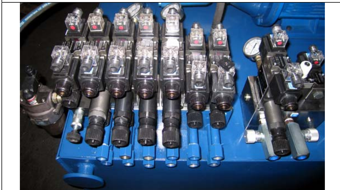
نصب ۳۹ عدد شیر هیدرولیک کنترل جهت، کنترل دبی، رگولاتور فشار و ... در فضای محدود ( یونیت هیدرولیک مربوط به ماشین ابزار )
