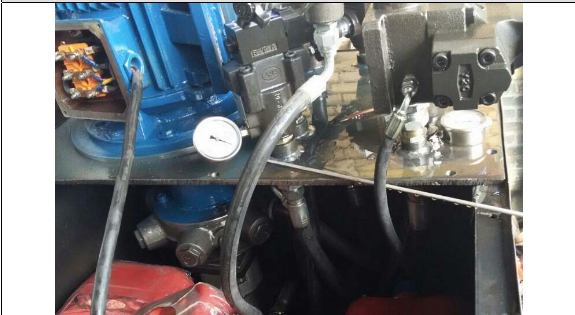
نمای داخل مخزن
