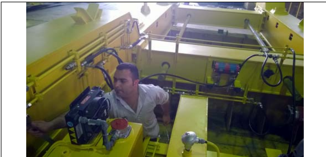
اجرای لوپ خطوط انتقال روغن
